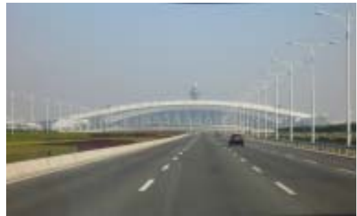
写真1 広州国際空港
