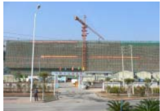
写真10 工事中の華南理工大學校舎
